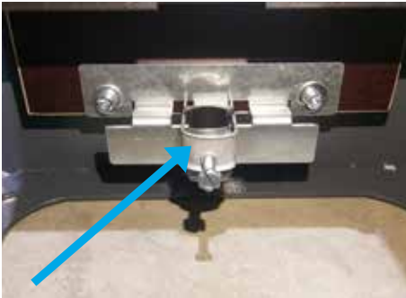
Figuur 5: Trekontlasting type PUK
